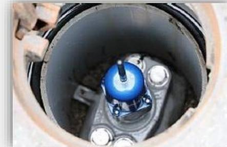
制水弁へ取り付けたセンサ
