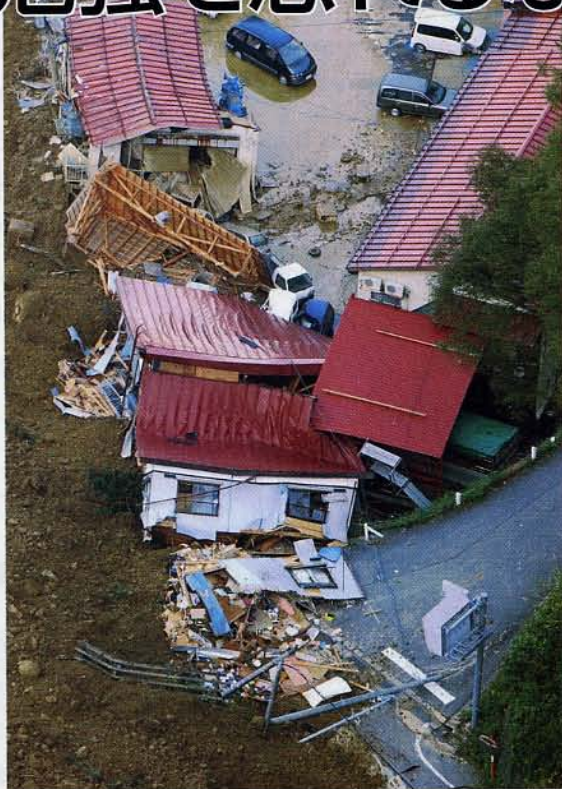
新潟県中越地震で倒壊した住宅(写真：共同通信社)
