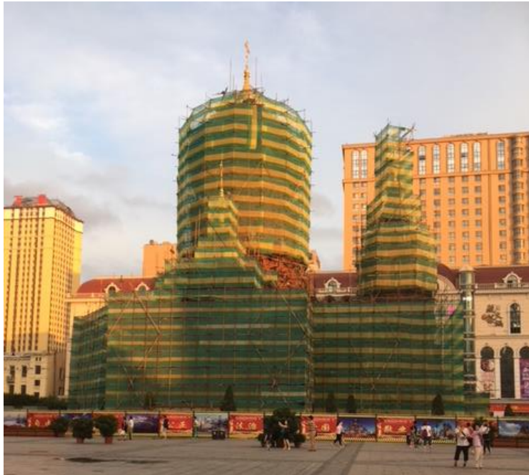
残念ながら工事中
